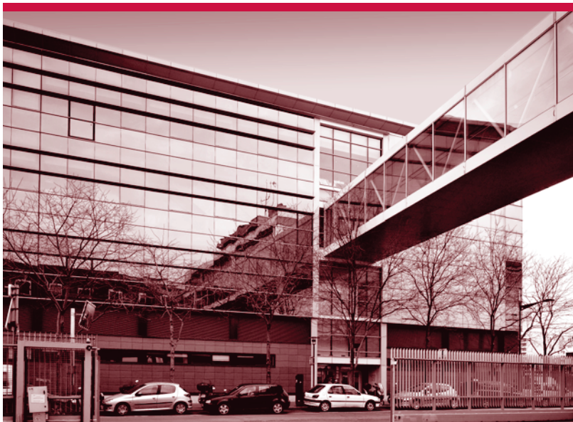
Courbevoie (92) • 47/49 rue des Fauvelles
